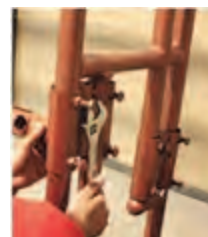
شکل ۱۸- بستن پیچ‌های قطعات دستگاه
