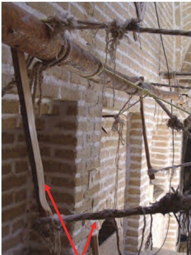
شکل ۳۶- کمونه و نخ اتصال آن
