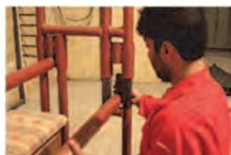
شکل ۱۷- نصب اجزاء دستگاه
