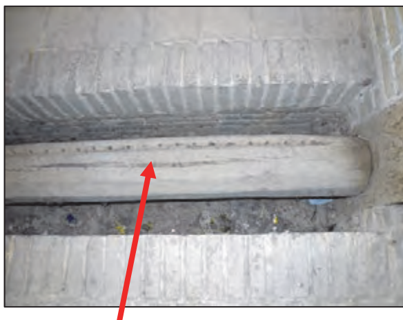
شکل ۳۲- حفره‌های تعبیه شده در تیر پایین (دماغه تیر)
