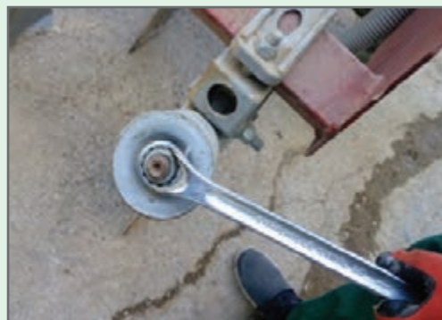
شکل ۴۵- آچارکشی نقاط اتصال اجزا و قطعات
