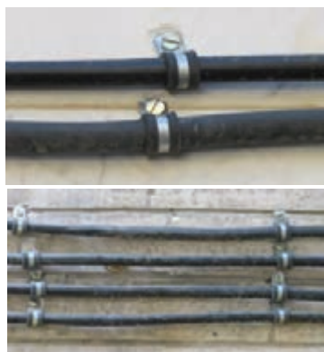
شکل ۲۵- کابل‌کشی روی دیوار
