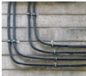
شکل ۲۱- خمش کابل
