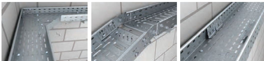
شکل ۴۴- اتصالات سینی کابل
