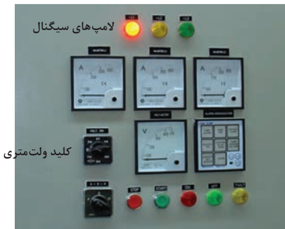
شکل ۷۳- کلید ولت متری و لامپ سیگنال معمولی
