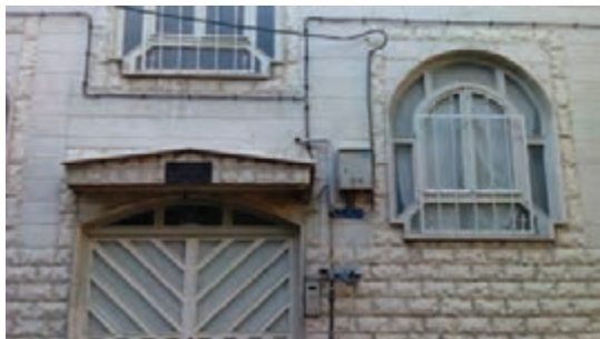
شکل ۱- کابل کشی روی دیوار
