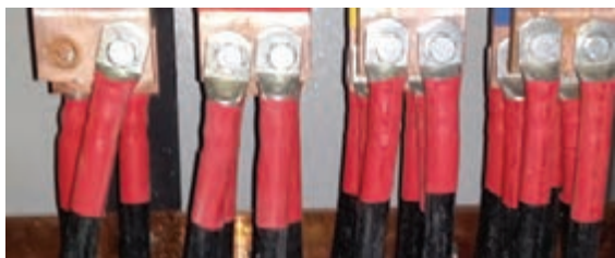
شکل ۱۷- عایق حرارتی کابلشو
