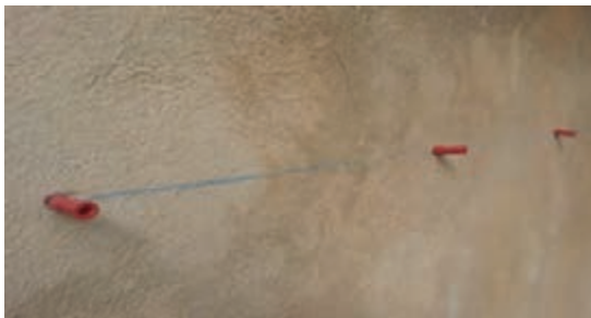
شکل ۳۵- نصب رول پلاک‌ها
