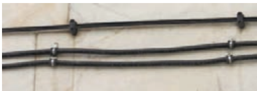
شکل ۲۷ - فاصله بین بست‌ها
