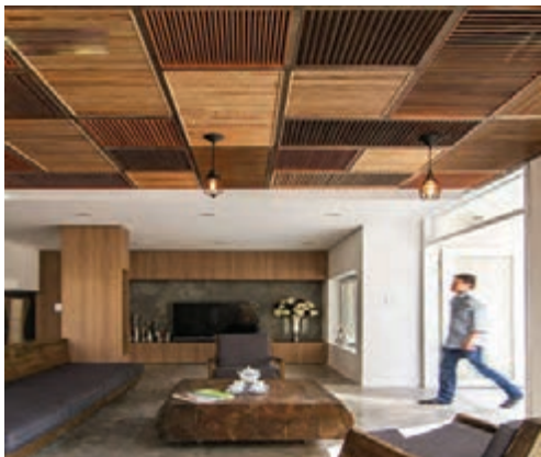
شکل ۲۶-۴- تزئینات سقف کاذب چوبی
