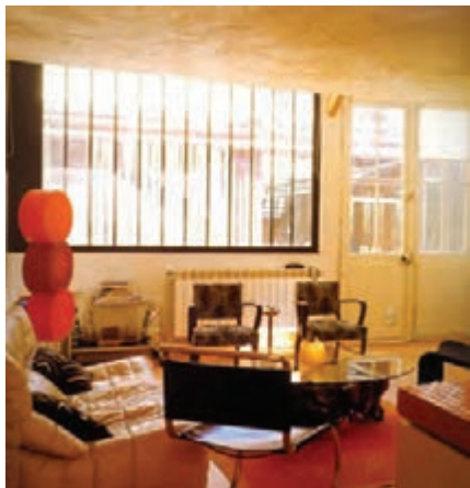
شکل ۹۳-۲ و شکل ۹۴-۲: نصب رادیاتور در زیر پنجره در فضای نشیمن و کنار پله
