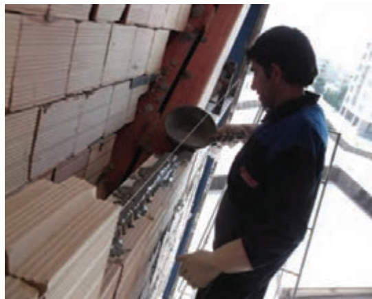
شکل ۴-۶- ملات ماسه سیمان جهت اتصال بلوکها
