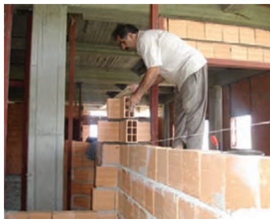
شکل ۱-۴- ریسمان کشی جهت اجرای مستقیم دیوار
