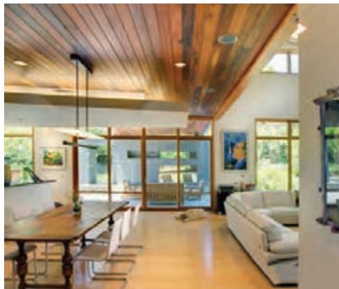
شکل ۲۵-۴- سقف لمبه کوبی شده چوبی
