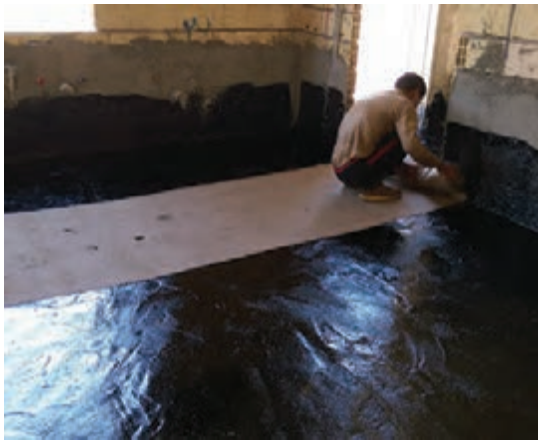
شکل ۱۱-۴- اجرای قیرگونی کف فضای داخلی
