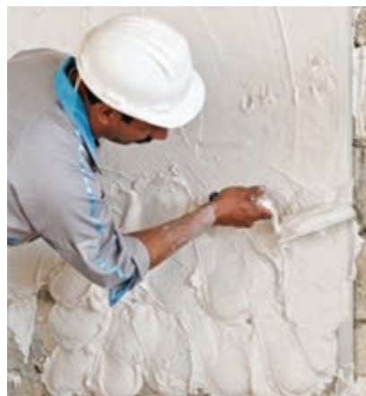
شکل ۱۶-۴- جزئیات نحوه ماله‌کشی و شمشه‌گیری اندود گچی دیوار
