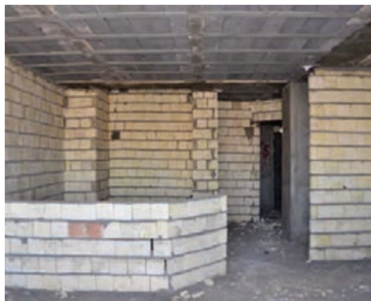
شکل ۴-۴- تیغه چینی داخلی با بلوک سفالی
