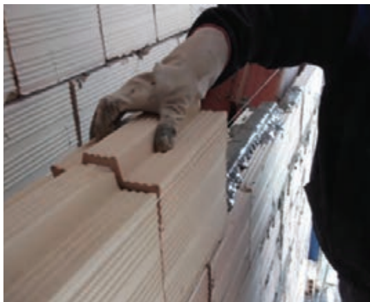
شکل ۴-۵- اجرای بلوک سفالی در امتداد ریسمان
