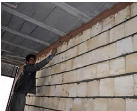
شکل ۲-۴- اجرای دیوار چینی با بلوک سفالی
