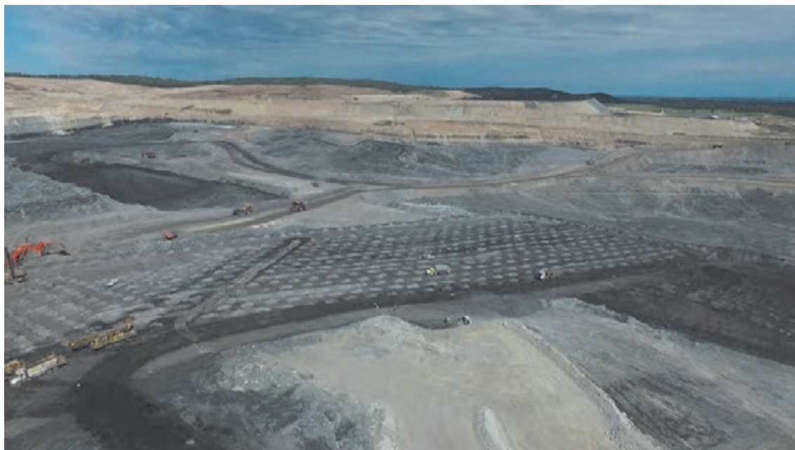
شبکه چال آتشیاری حفر شده
