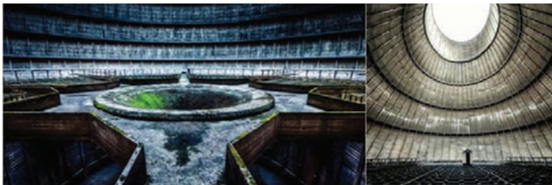
شکل ۲۴- خوردگی و رشد میکروارگانیسم‌ها در برج‌های خنک کننده
