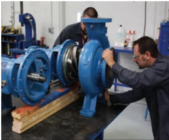
شکل ۲- تعمیر اساسی پمپ در کارگاه مکانیک
