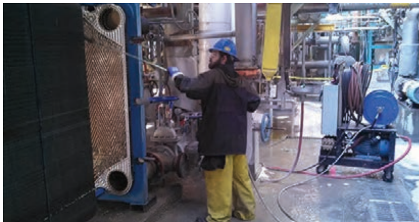
شکل ۱۵- روش فشار آب (جت آب)
