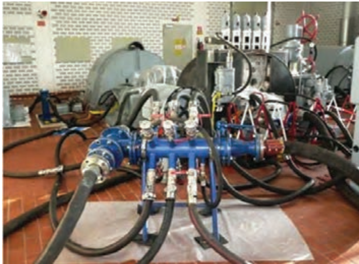
شکل ۳۰- سامانه تمیزکاری کمپرسور
