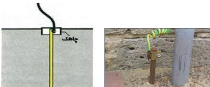
شکل ۴ - شیوه اتصال به چاه ارت
