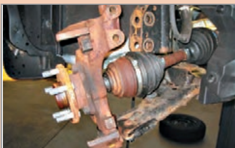
۲- باز کردن پایه کمک‌فنر از سگدست (در صورت لزوم)
