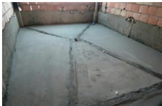
اجرای کرم و بتن شیب‌بندی حمام
