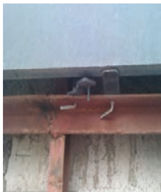
اتصال قطعات زیرسازی سنگ به دیوار
