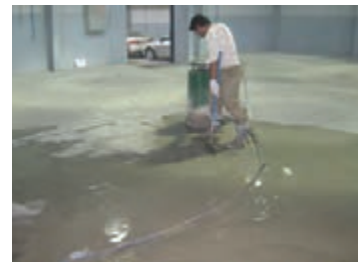
اجرای ملات برای مسطح کردن سطح
