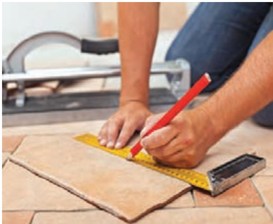
مشخص کردن مسیر برش سرامیک
