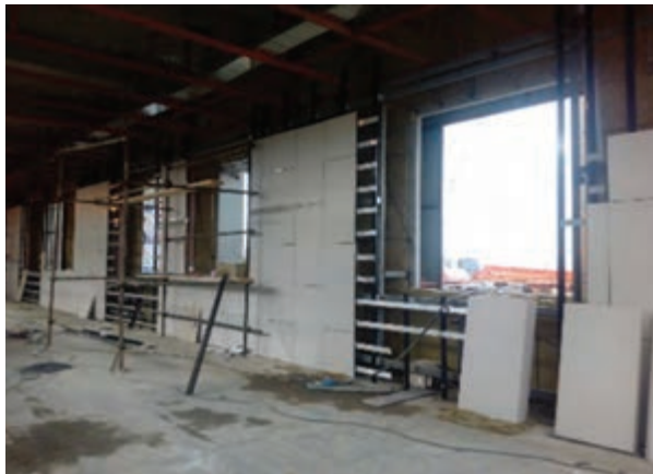
اجرای زیرسازی فلزی
