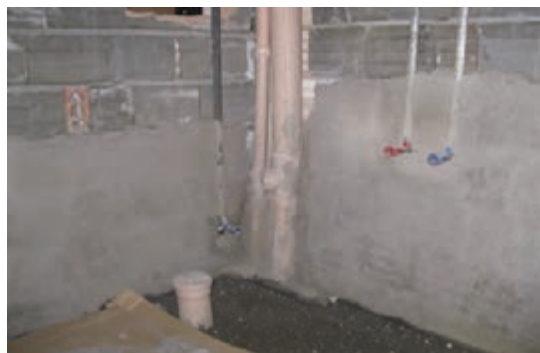
بستر عایق در روی دیوار هم مانند کف باید با ملات ماسه سیمان لیسهای اجرا می‌شود.
