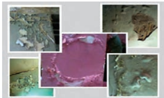
جذب آب توسط کف، کپک و پوسیدگی مصالح در سطح کف
