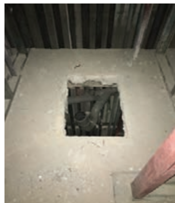
حفره جهت نصب سبد
