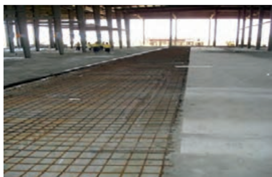
اجرای بتن کف
