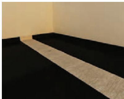
۱- آماده‌سازی کف قبل از اجرای عایق
