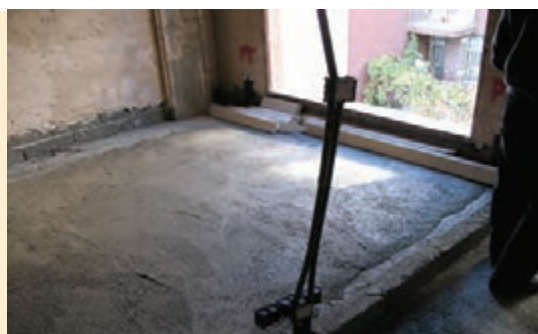
کنترل کف فضا قبل از اجرای کف پوش
