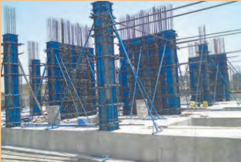
قالب‌بندی و آرماتوربندی ستون
