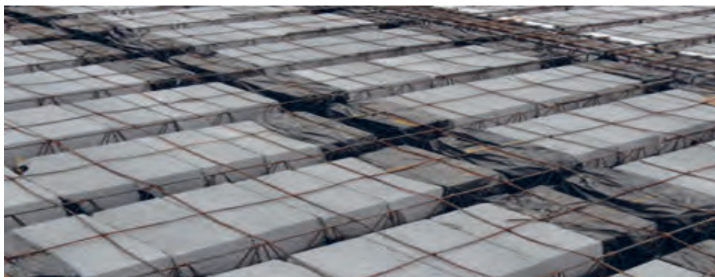
اجرای شناژ مخفی در سقف تیرچه بلوک
