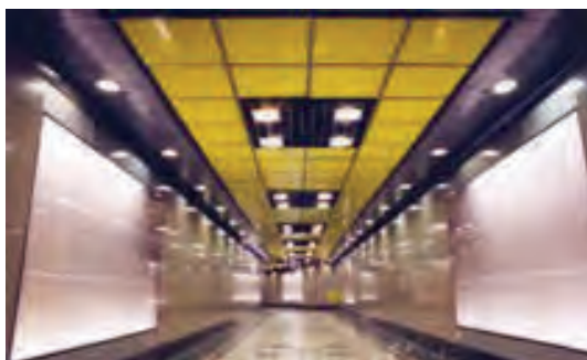
سقف کاذب تایل آلومینیومی با شبکه فلزی
