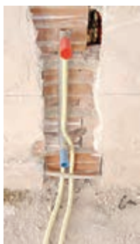
شکل ۶۲- اتصال سر لوله رادیاتور با شابلون زیر کار
