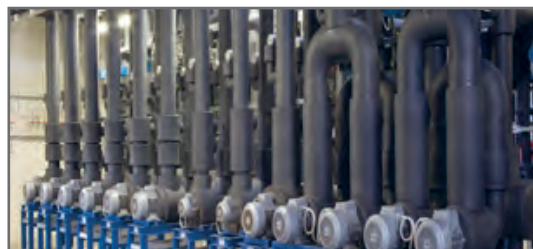
شکل ۳۳- عایق الاستومری بدون پوشش آلومینیوم
