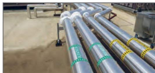
شکل ۳۴- عایق الاستومری با پوشش آلومینیوم
