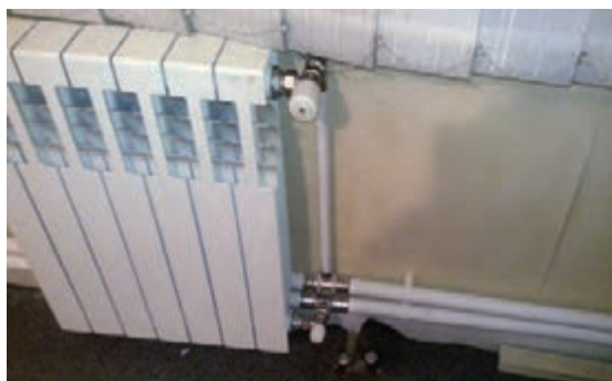
شکل ۶۱- اتصال سر لوله رادیاتور روکار
