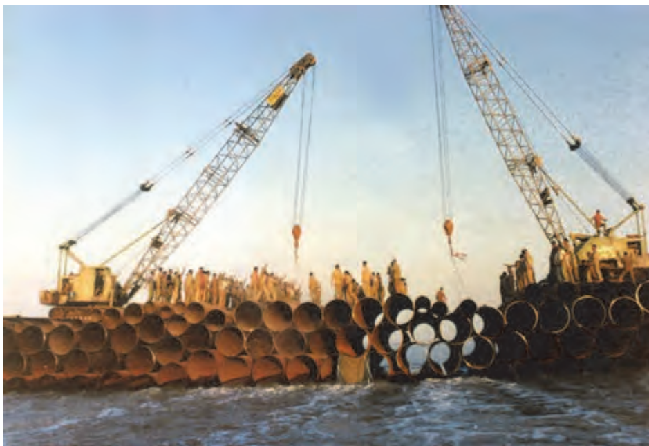
شکل ۱۱-۵- پل بعثت در حال ساخت
