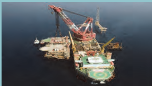
عملیات نصب سکوی فاز ۱۹ پارس جنوبی در خلیج همیشه فارس با به‌کارگیری از یکی از مدرن‌ترین شناورهای نصاب منطقه (اوشنیک ۵۰۰۰)
