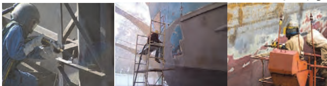
شکل ۱-۷ زنگ‌زدایی در اسکله خشک
