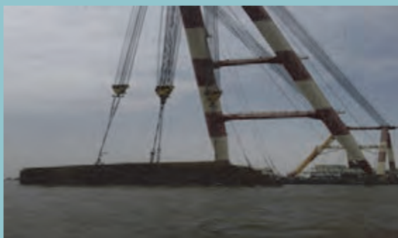
عملیات خارج‌سازی شناور "کارون بار" با استفاده از جرثقیل شناور از قعر آب‌های ارون‌رود
