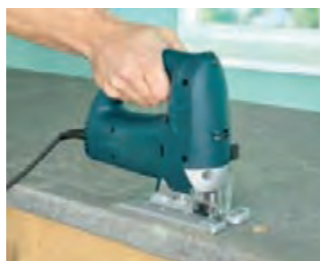
شکل ۱۰۱- برش کاری محل قرارگیری سینک
