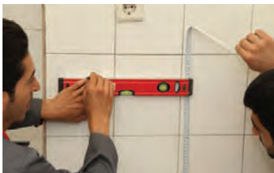
شکل ۹ - اندازه گذاری روی دیوار آشپزخانه برای ترسیم خط تراز
