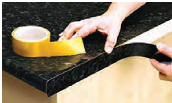
شکل ۱۱۹ - نصب نوار لبه صفحه تاپس
