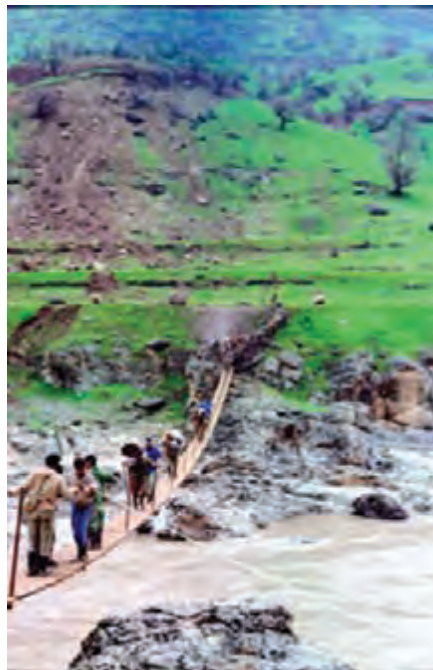
نمونه‌هایی از طرح و اجرای پل نفرو
