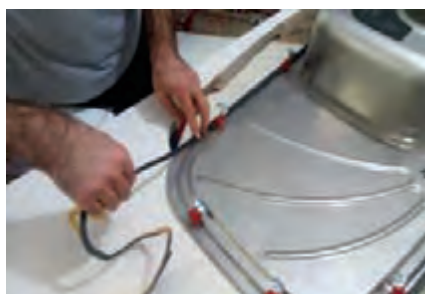
شکل ۱۰۴- نصب نوار آب بندی پشت لبه سینک
