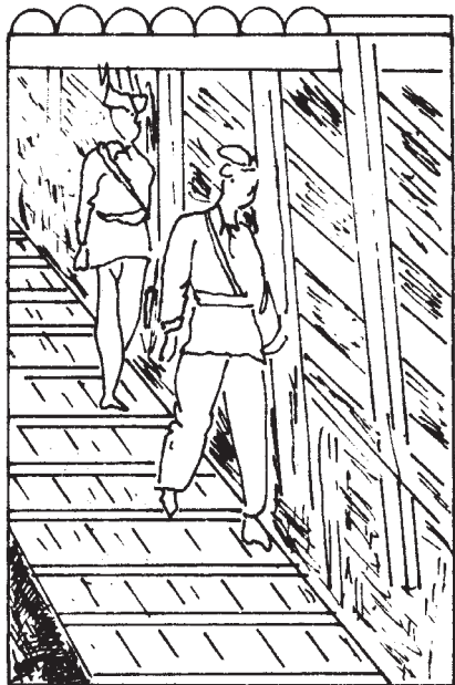
شکل ۴-۱۶- گذرگاه مخصوص کارگران (۶)
