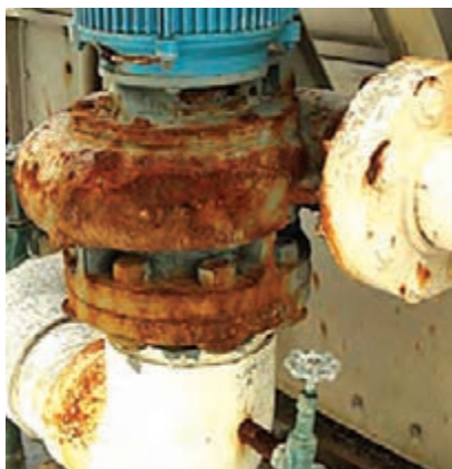
شکل ۵-۷- تأثیرات شیمیایی روی قطعات
