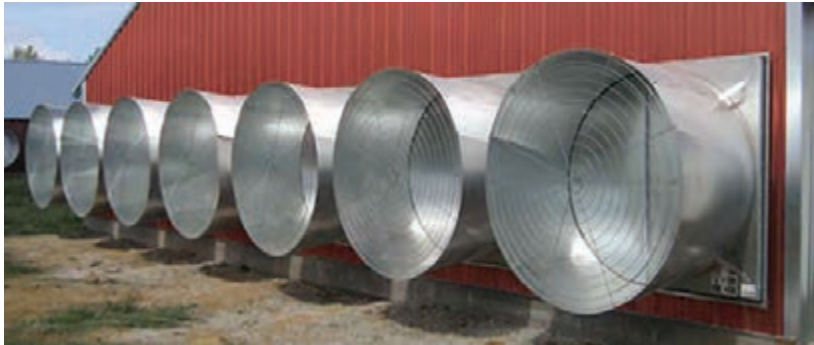
استفاده از هواکش ها در تهویه سالن پرورش
