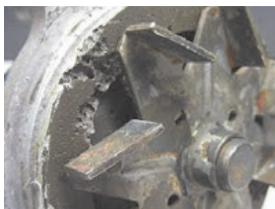
(ج) خرابی بلبرینگ و خوردگی داخلی
