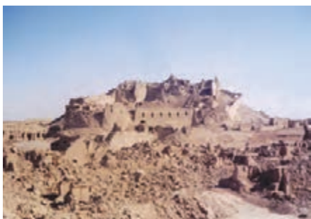
ج) ارگ بم بعد از زلزله
