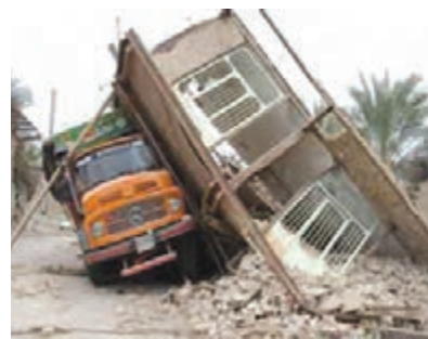
الف) ریزش دیوار در اثر زلزله
