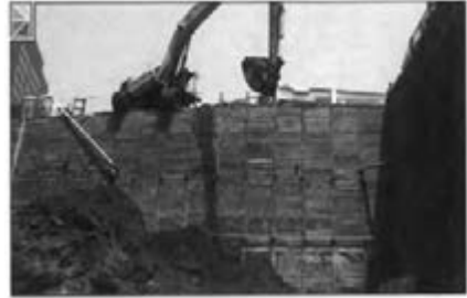
شکل ۱- ضرورت رعایت ایمنی در عملیات گودبرداری
