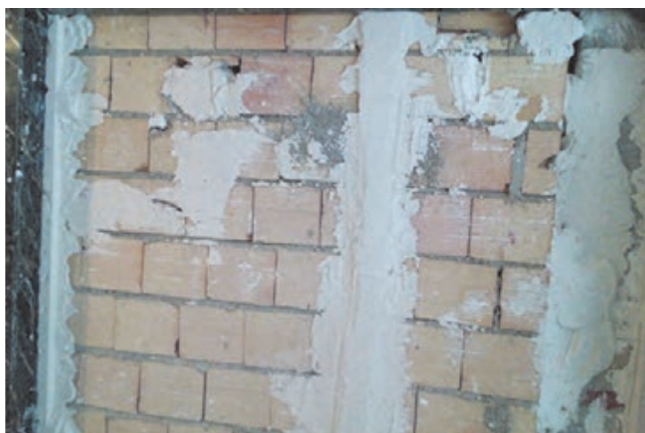
شکل ۲۴ ▲ شمشه‌گیری بین کرم‌ها
