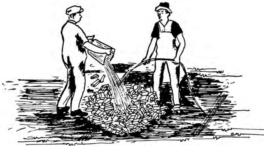
شکل ۳۷ ▲ زنجاب کردن آجر
