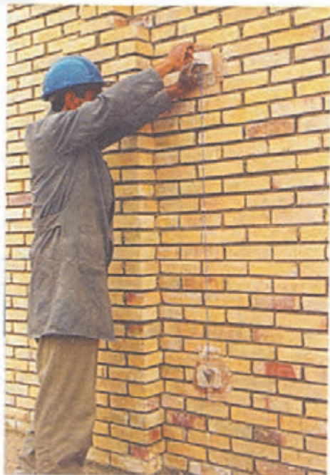
▲ شکل ۲۰ شاقولی کردن کرم‌ها
