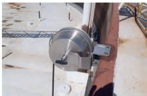
شکل ۴-۲۶- تخلیه الکتریسیته ساکن در مخزن سقف شناور
