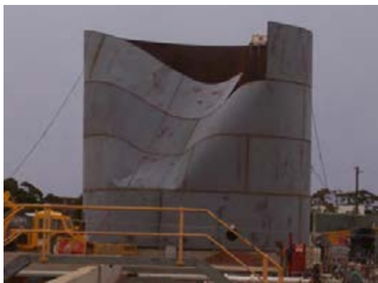
شکل ۴-۲۷- آسیب دیدن مخزن به دلیل وزش باد
