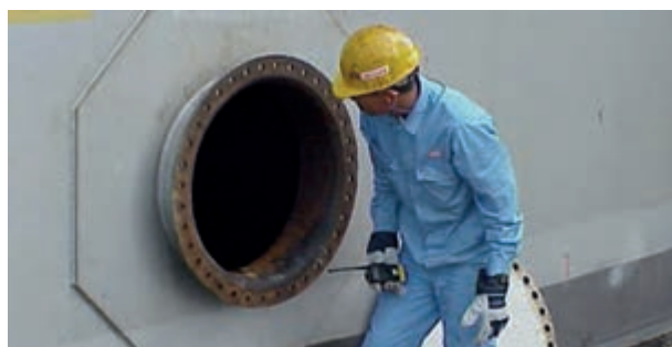
شکل ۲۱-۴- دریچه آدم‌رو مخزن
