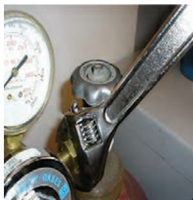
بازکردن شیر تنظیم از کپسول
