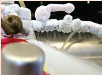
شکل ۱۲-۵- شیر و اتصالات یخ‌زده
