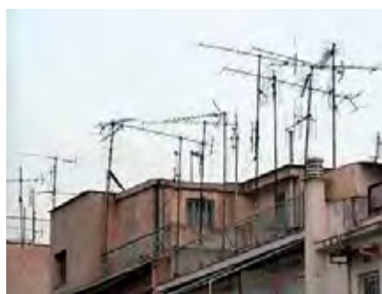
شکل ۳- تعداد زیاد آنتن نصب شده روی بام چشم‌انداز ناخوشایندی ایجاد می‌کند.
