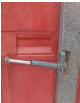
شکل ۲۱- جک هیدرولیک با فشار روغن
