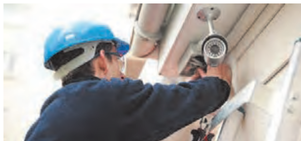
شکل ۲۹- نصب دوربین در فضای مناسب
