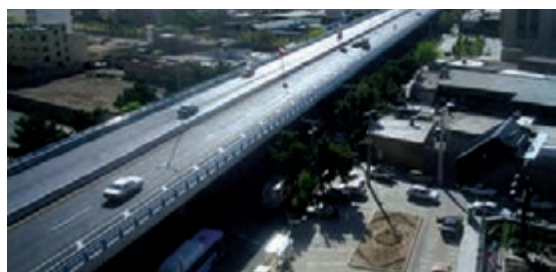
پل روگذر آزادراه از جنس فولاد آلیاژی
