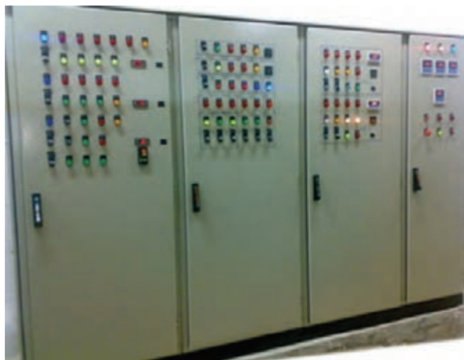
شکل ۱۳- تابلو توزیع برق صنعتی
