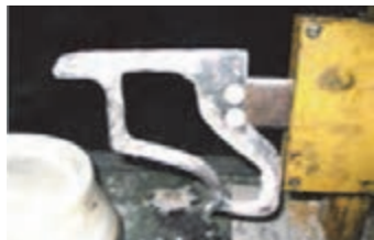
ب) نصب و تنظیم شابلون
