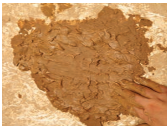
شکل ۱۰- تهیه گل یکنواخت با دوغاب
