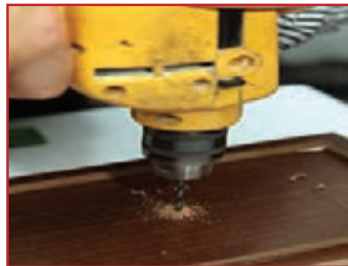
پ) سوراخ کردن در جعبه با دریل
